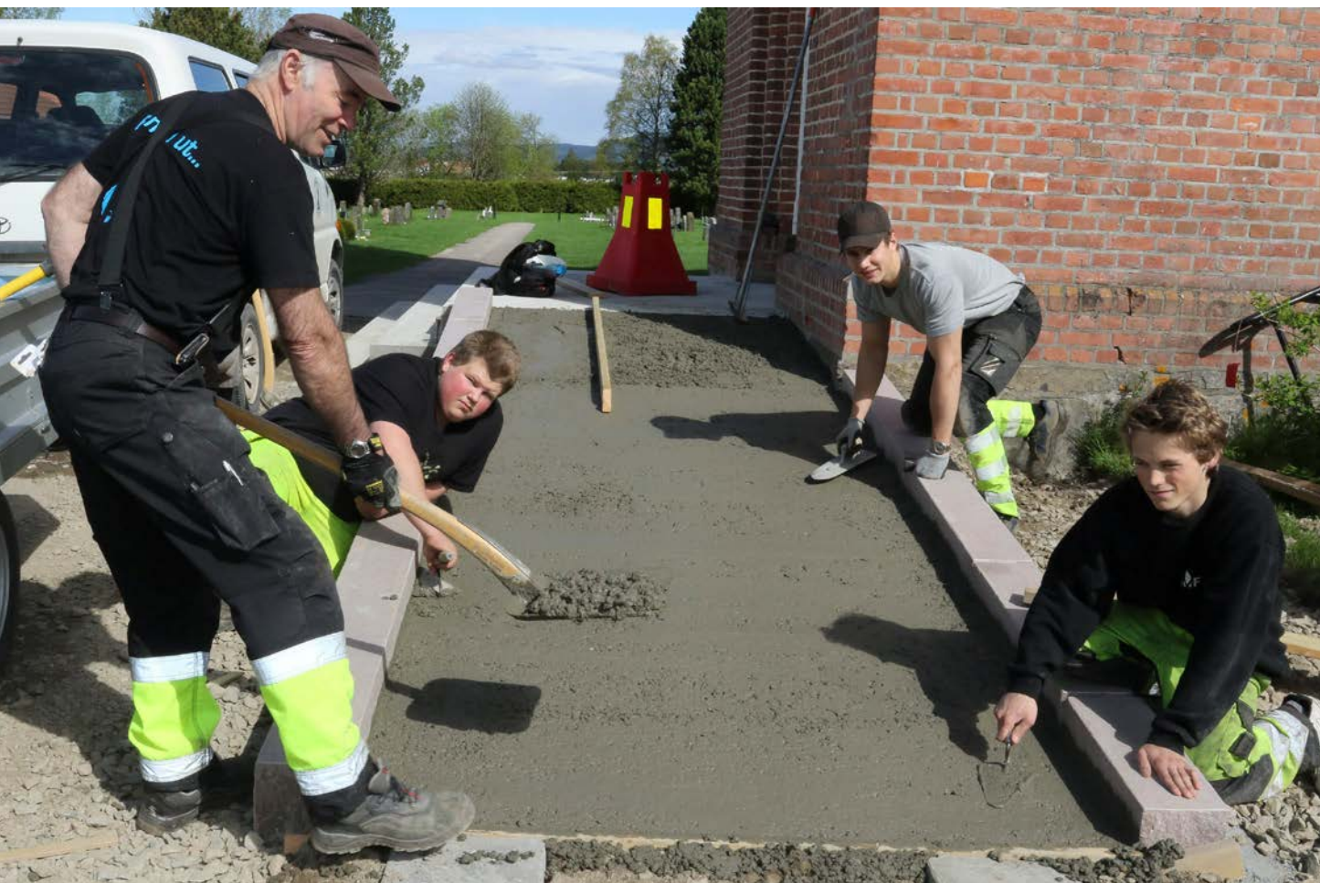
NY ADKOMST: Elever fra anleggsgartnerlinja på Solør videregående skole bygger ny adkomst til Hof kirke i 2015. Fra venstre: lærer Steinar Varpe, elevene Jan Sverre Tasigtil, Allexander Stortiset og Steffen Korneliussen. (Foto: Sverre Vigen/Østlendingen)
