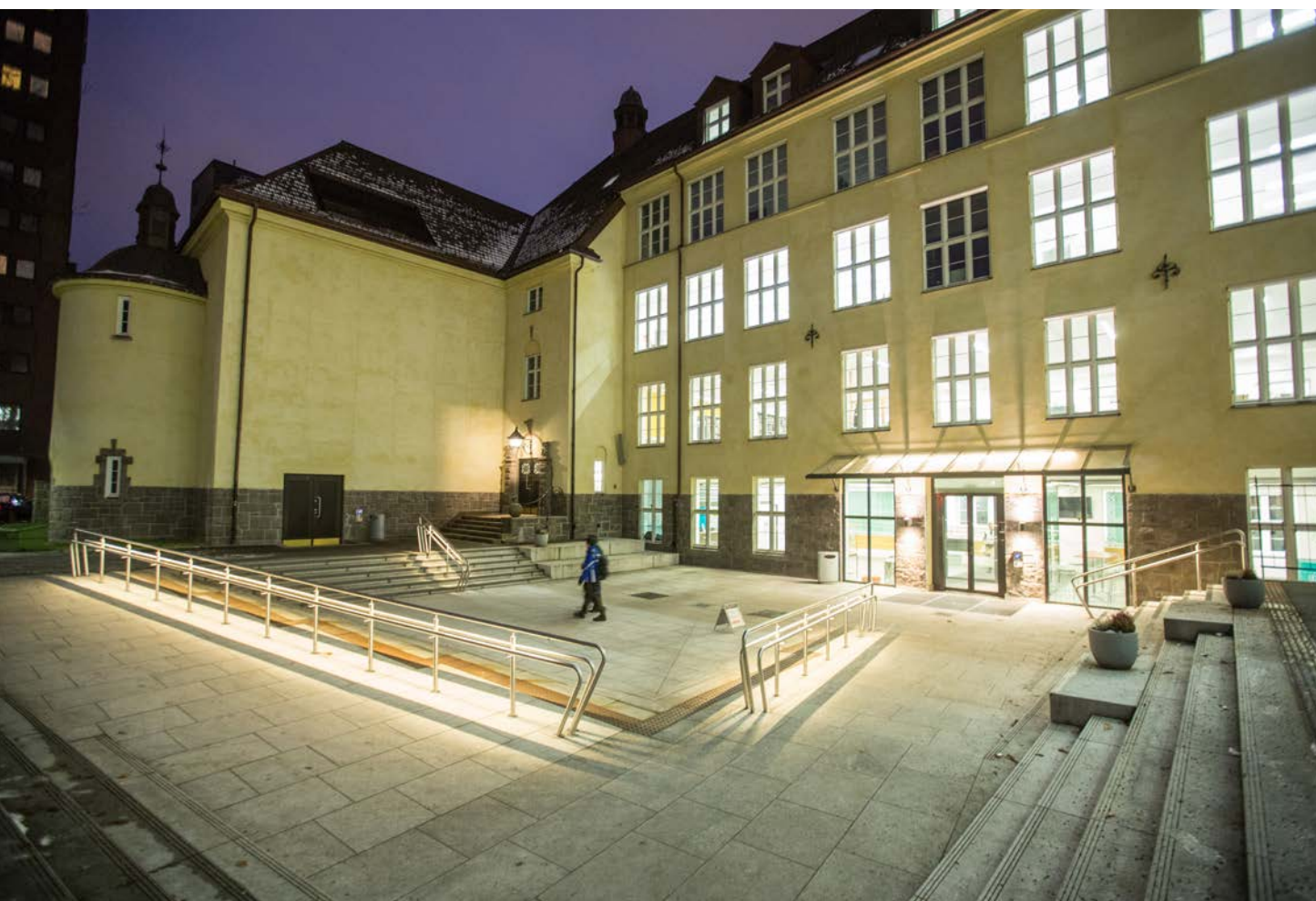
NY OG NEDSENKET: Det nye, nedsenkede inngangspartiet føyer seg elegant inn i den gamle fasaden. Rampen og ledelinjene er visuelt godt integrert i skolegården for øvrig. (Foto: Fredrik Naumann/Felix Features)
