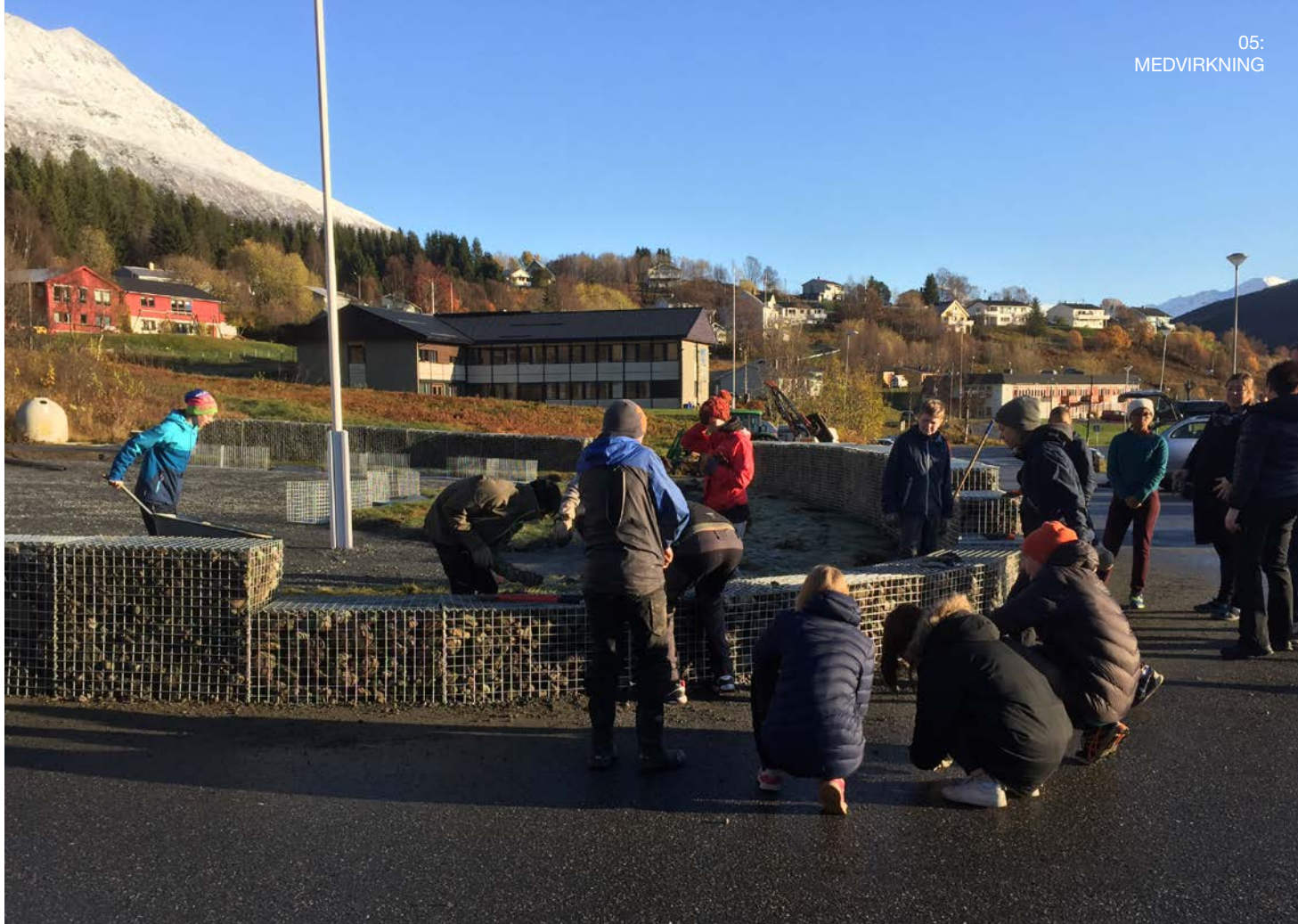
DUGNAD: Elever fra Montessorrskolen Morgan var blant de 50 innbyggerne i Gratangen som hjalp til å bygge gabioner – som omkranser den nye sansehagen. (Foto: Rita Roaldsen)
